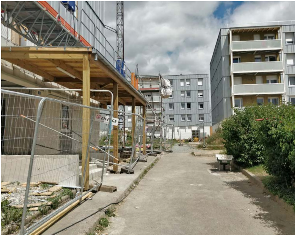
Une réhabilitation ambitieuse d'une partie des logements
