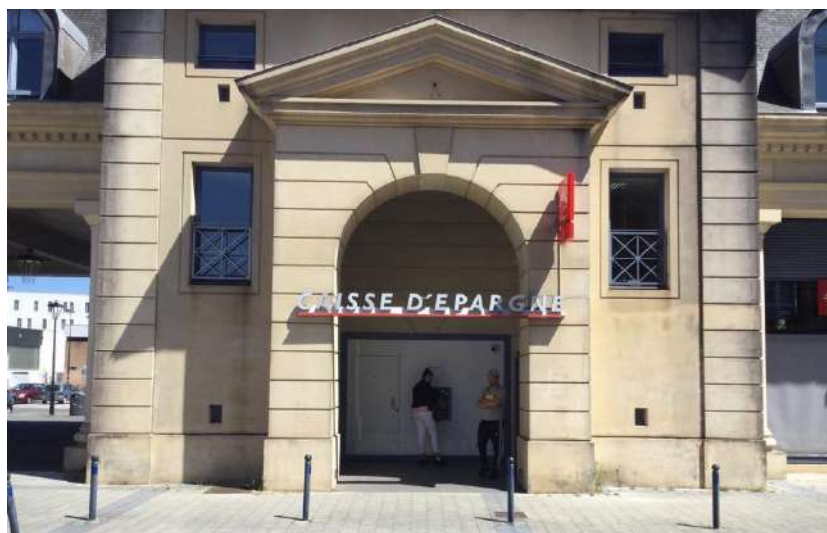
Enseigne parallèle au mur ne mettant pas en valeur l'architecture du bâtiment sur lequel elle est installée, Lanester, juillet 2019.
