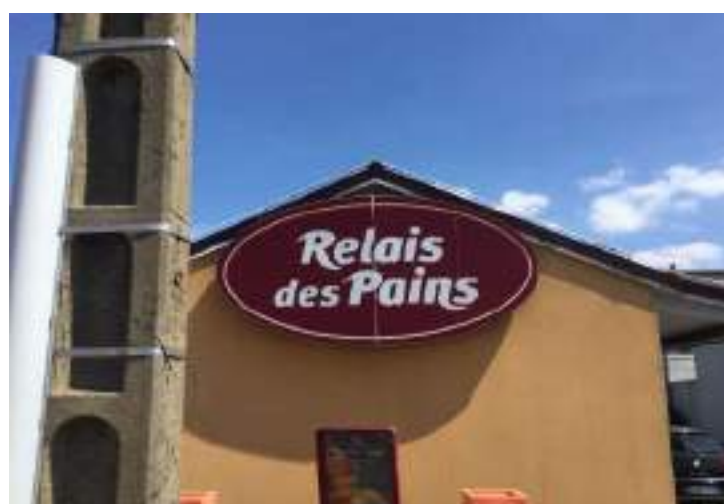
Enseignes parallèles au mur dépassant des limites de l'égout du toit, Lanester, juillet 2019.
