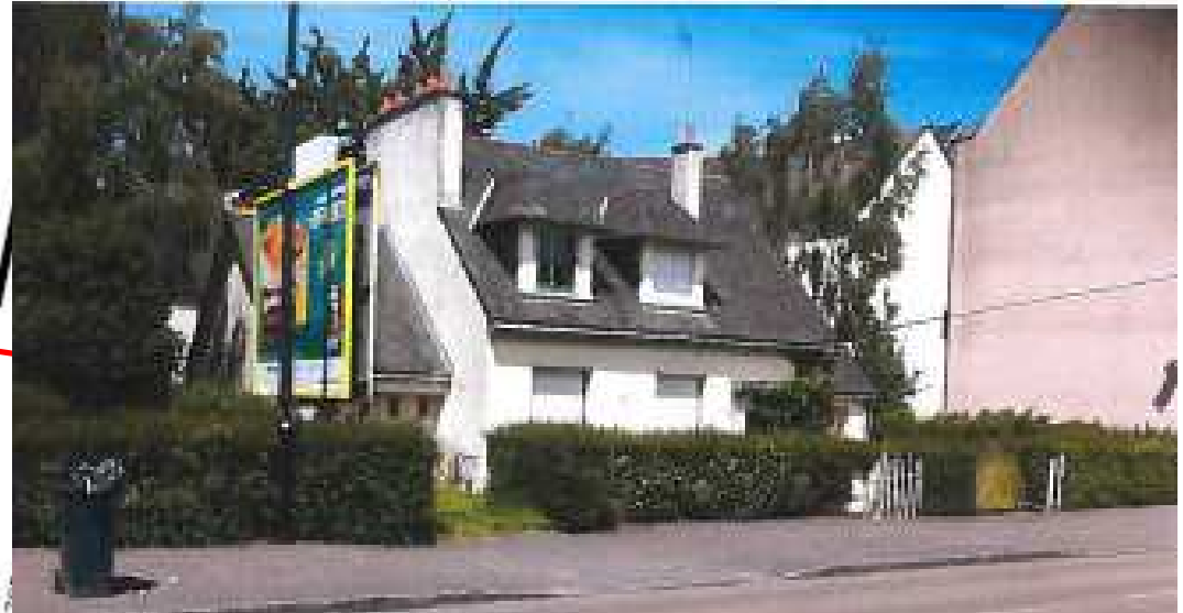
Maison à démolir. 71 rue Marcel Sembat - Lanester
