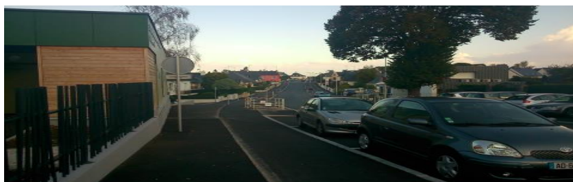
FIGURE 3 : TRAVAUX SUR L'AVENUE STALINGRAD ET AU RESTAURANT SCOLAIRE HENRI BARBUSSE
